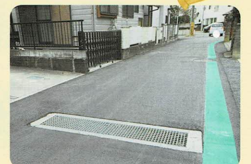
雨水浸透マスを設置
