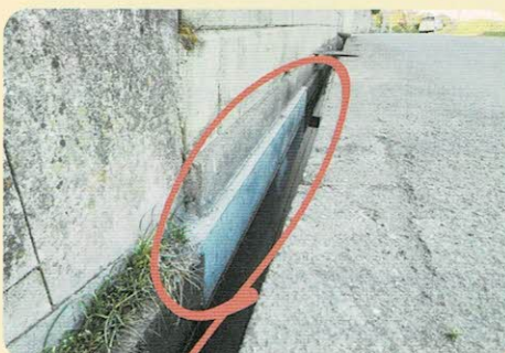
道路側溝の補修
