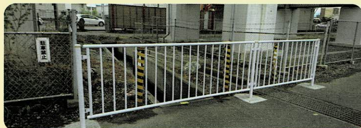
水路への転落防止柵を設置
